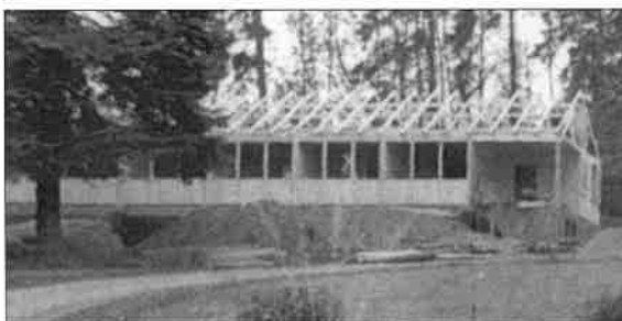
Das „Haus am Walde“ wird gebaut.
