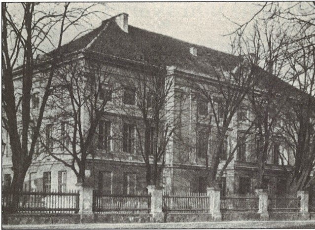
Das alte Klassengebäude von 1820.
